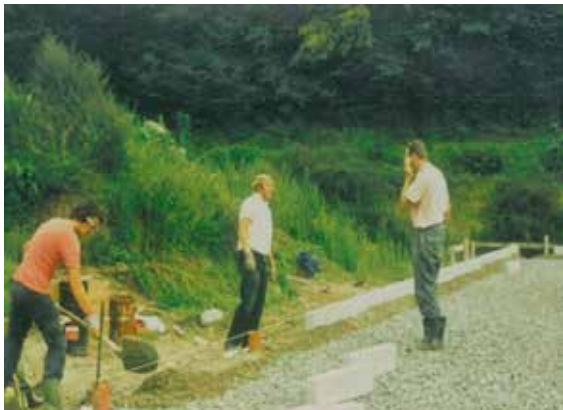
10 | ... konnten die Kantensteine gesetzt werden.
