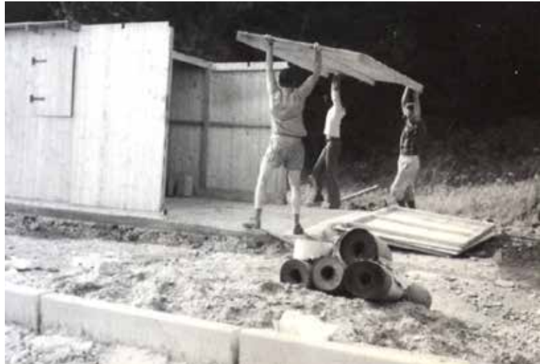
14 | Aufbau der Hütte
