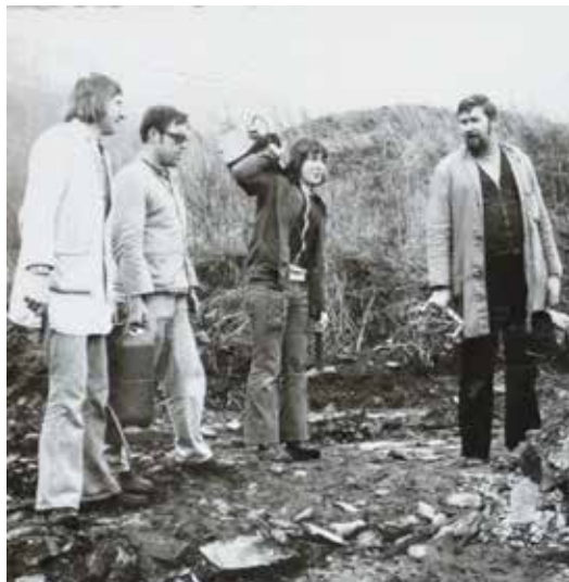
4 | Die Wasserversorgung legten Gerd Kaltenbach und seine Kollegen.
