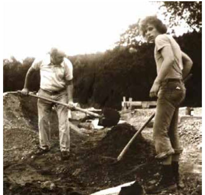
7 | schweißtreibende Arbeiten an der Schütte
